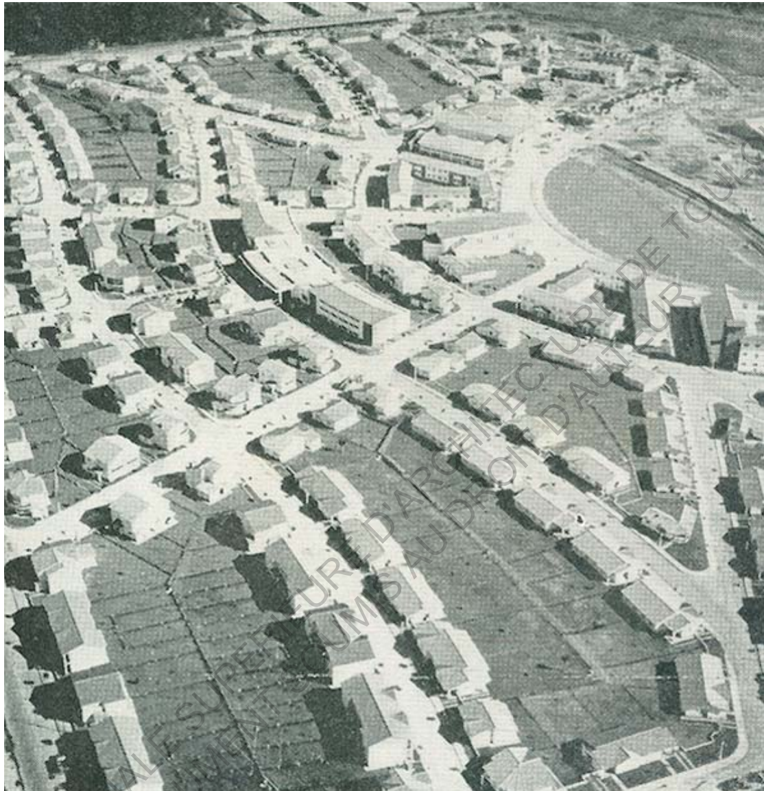
Vue générale du quartier*
